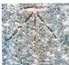
A 0,13 m de la parte lateral del soporte del arco
